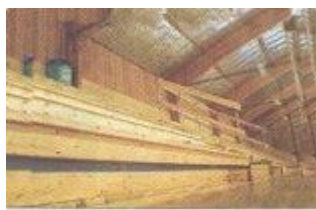
Ett lyft för ishallen. Jonny tycker läktaren blev ett lyft för hallen. Den byggdes 1973.
